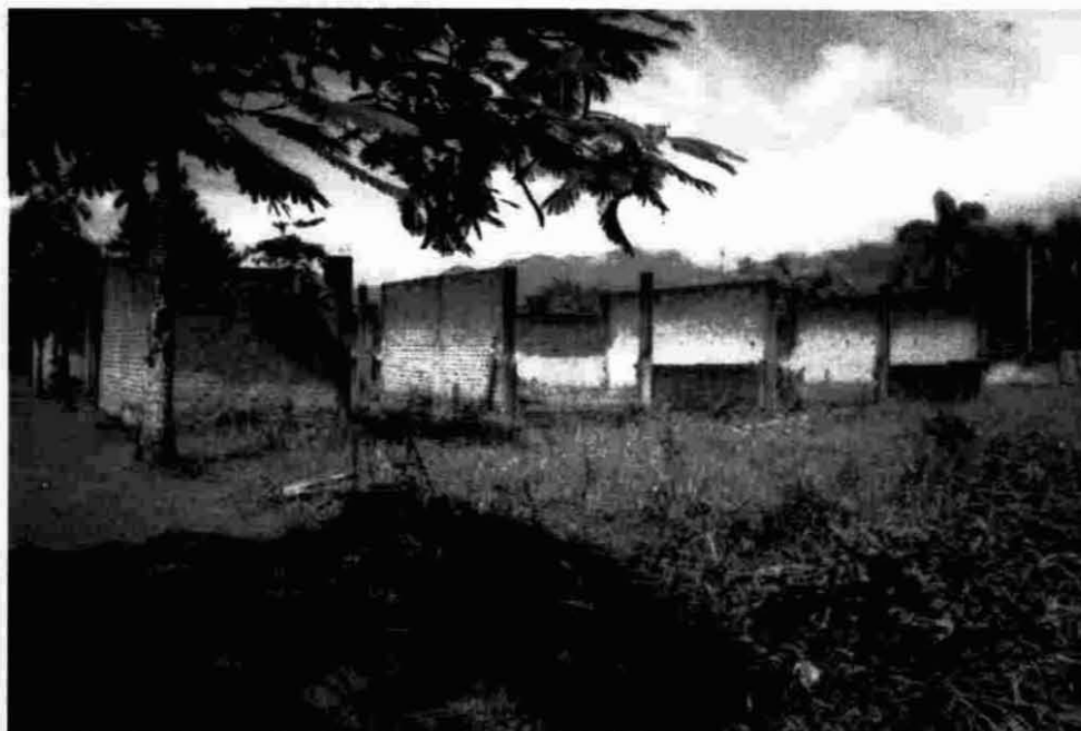
Ainda em Morretes, as obras de ampliação do Colégio professor Arlindo de Castro estão paralisadas desde 1993
