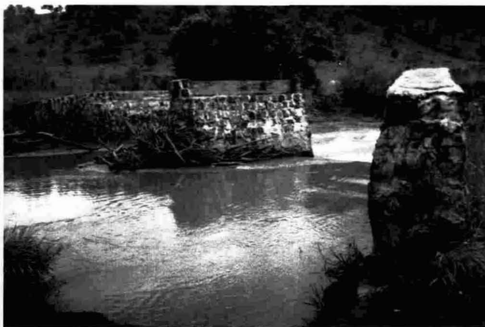
No interior do Estado, técnicos do Tribunal de Contas se depararam com obras de artes inacabadas, como esta ponte que aos poucos vai se desintegrando. Ponte sobre o Rio da Paz, em Lindoeste
