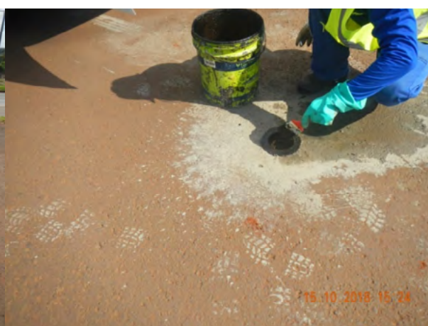
Fechamento do furo de sondagem
